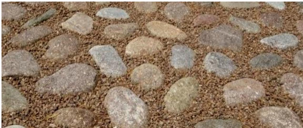
Rappresentazione della soluzione utilizzando il Sistema MASsecco<sup>®</sup> come supporto per la pavimentazione in ACCIOTTOLATO. Il tutto è realizzato a secco senza l'utilizzo di cemento garantendo il drenaggio dell'acqua piovana prevedendo degli interstizi di cm 1,5-2 sigillati con sabbie fuganti ecologiche permeabili oppure con graniglia porfirica resinata.
